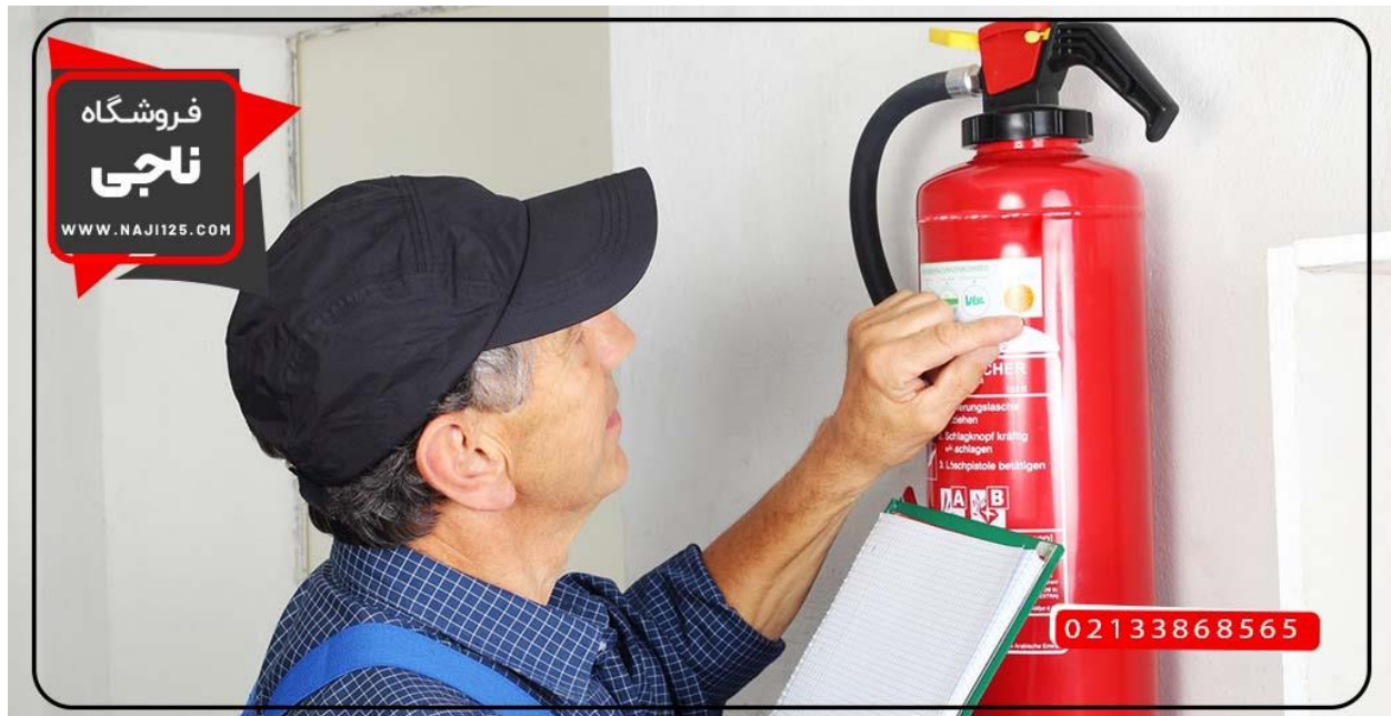
بررسی ماهانه کپسول آتش نشانی
